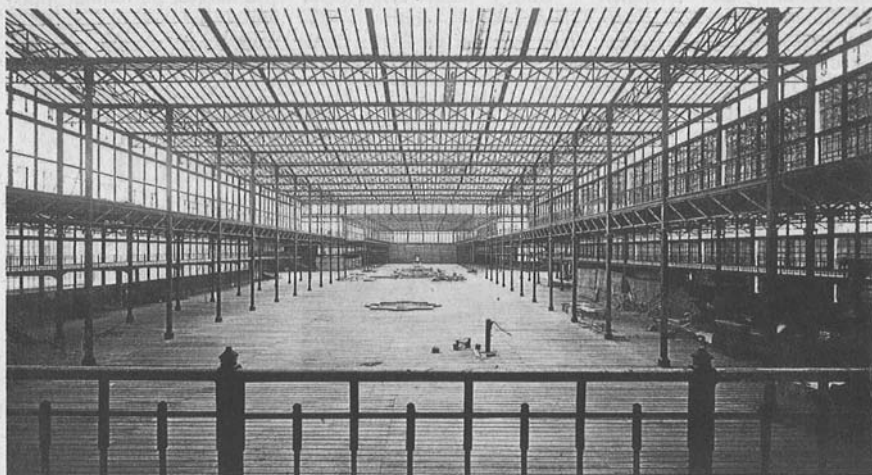
„Serielle Architektur“ aus Fertigteilen: Dazu gehörte der Münchner Glaspalast.
