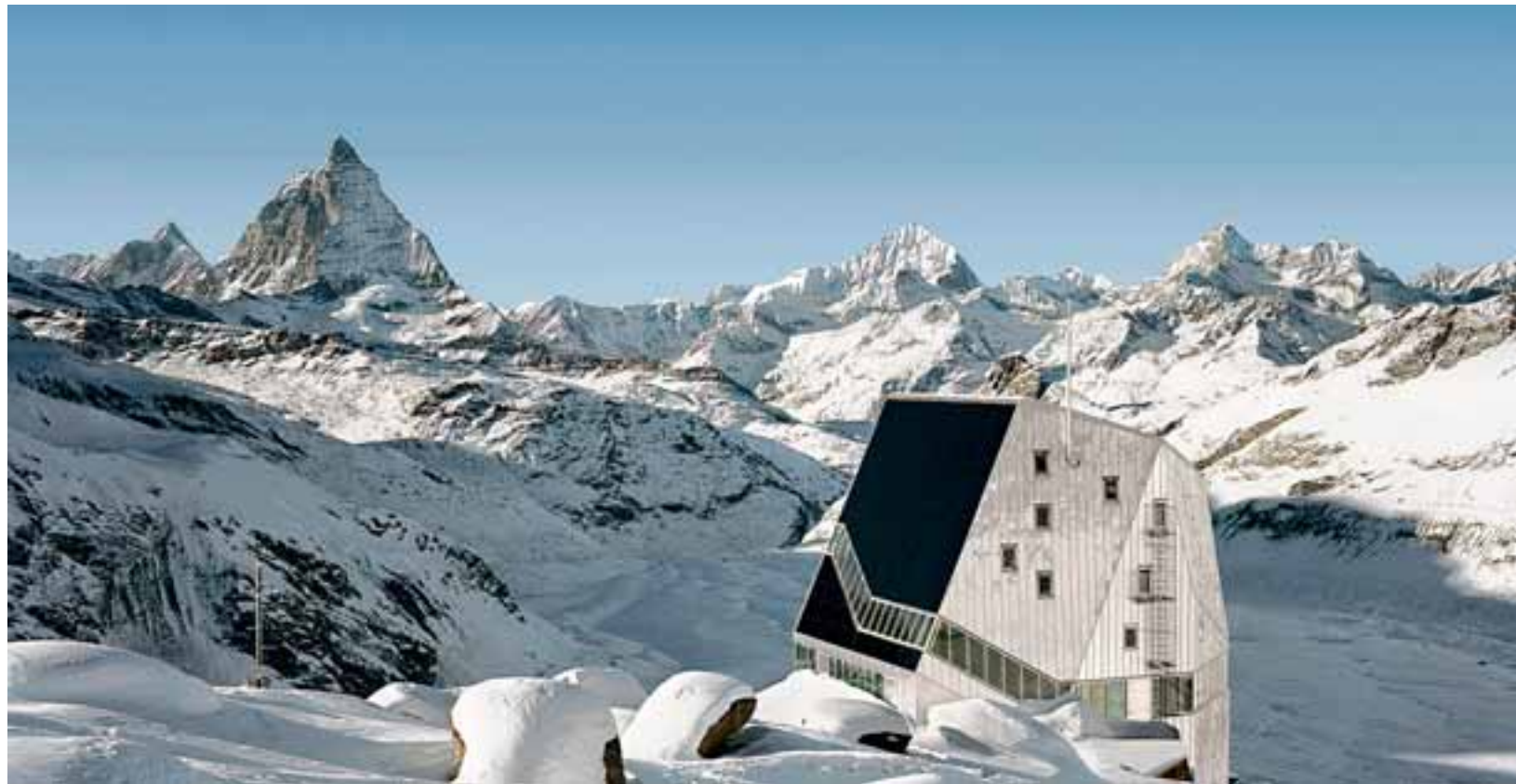
Als wär's ein großer Kristall im Eis: die Monte-Rosa-Hütte im Wallis, gebaut aus Holz.
