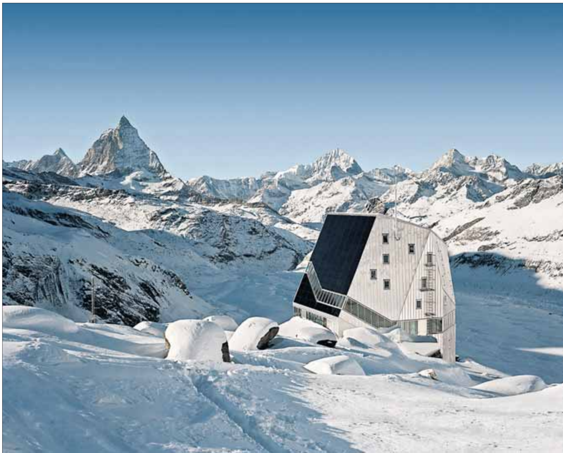
Unter der Hülle ganz aus Holz: Die Neue Monte Rosa Hütte von ETH-Studio Monte Rosa mit Bearth & Deplazes Architekten AG Foto: Tonatiuh Ambrosetti
