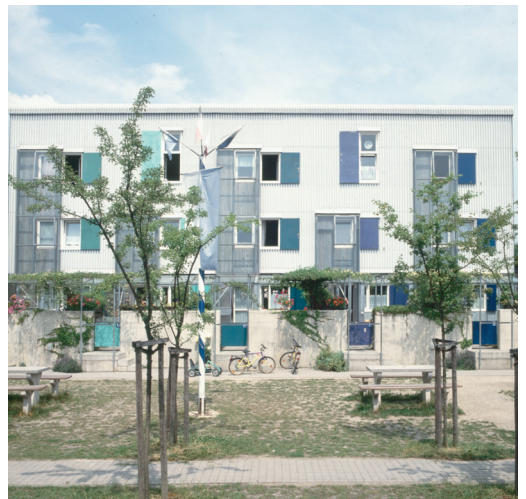
Bayerische Demonstrativbaumaßnahme Wohnanlage Passau-Neustift, Hermann, Schröder und Sampo Widmann, 1989
