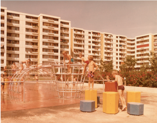
Großsiedlung Neuperlach Nordost, München, Egon Hartmann, 1974–1979
