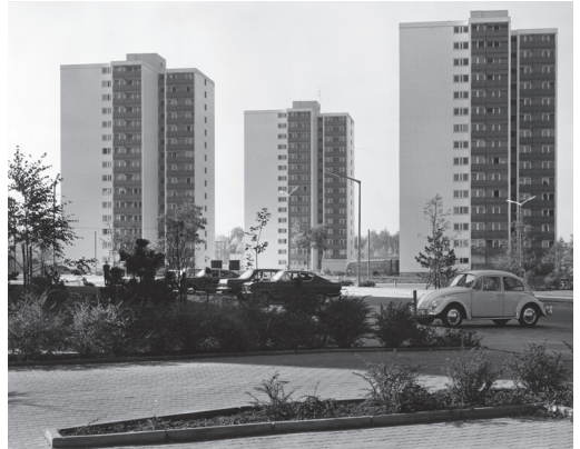
Großsiedlung Langwasser, Nürnberg, Franz Reichel (Gesamtplanung), ab 1956
