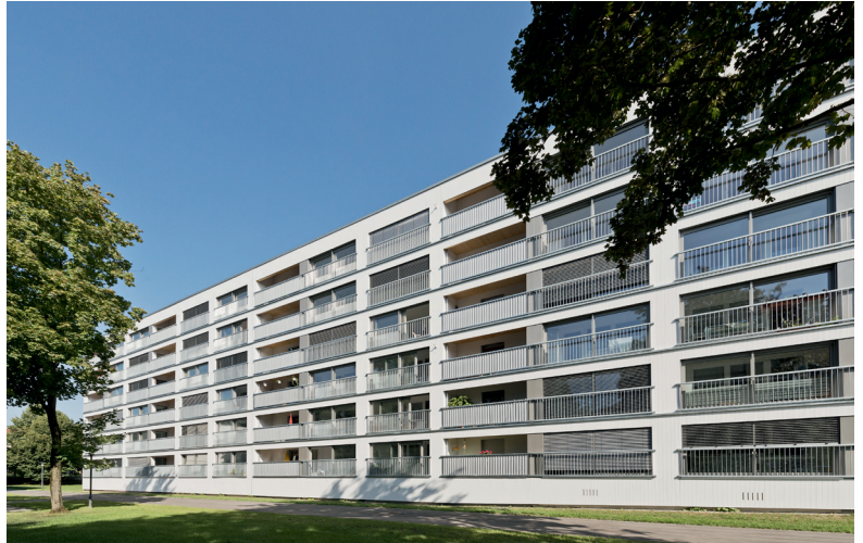
Modernisierung Wohnanlage in der Grünenstraße, Augsburg, lattkearchitekten, 2012
