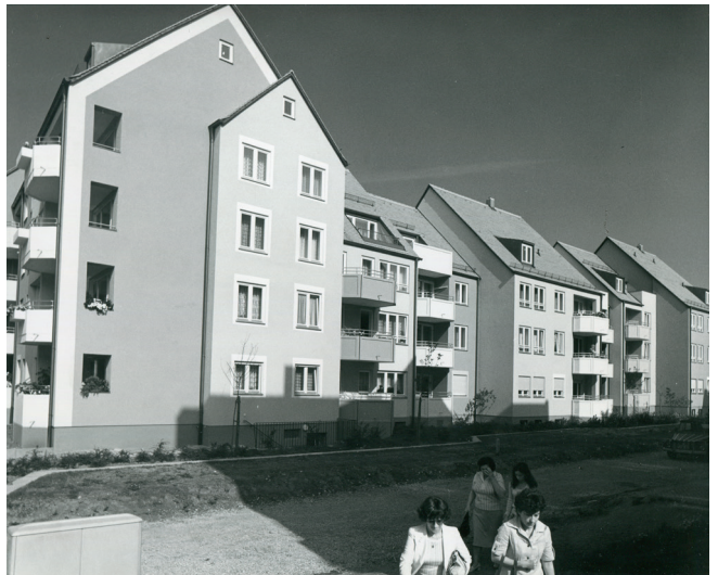
Flächensanierung Gänsberg, Haus Königstraße 34, Fürth, Neue Heimat Bayern, 1975
