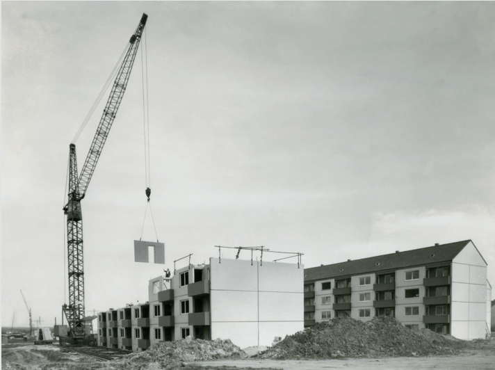
Großtafelbauweise in der Siedlung Nürnberg-Langwasser, 1963, Wohnungs- und Siedlungsbau Bayern
