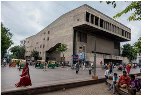
Außenansicht der Konzerthalle: »Premabhai Hall«, Ahmedabad, 1976 © Courtesy of Vastushilpa Foundation, Ahmedabad, Foto: Vinay Panjwani – India
