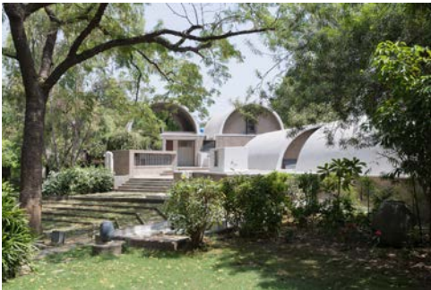
Blick vom Garten auf Doshis Bürogebäude: »Sangath Architect's Studio«, Ahmedabad, 1980 © Iwan Baan 2018
