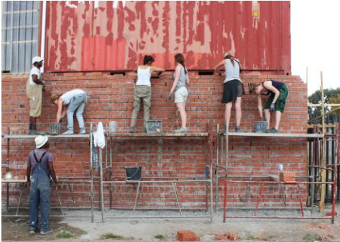
Baustelle des Guga S'Thebe Theaters in Kapstadt, Südafrika © RWTH AACHEN PBSA GATECH
