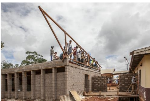
Baustelle des Operationsgebäudes vom Krankenhaus in Ngaoubela, Kamerun © TUM DesignBuild
