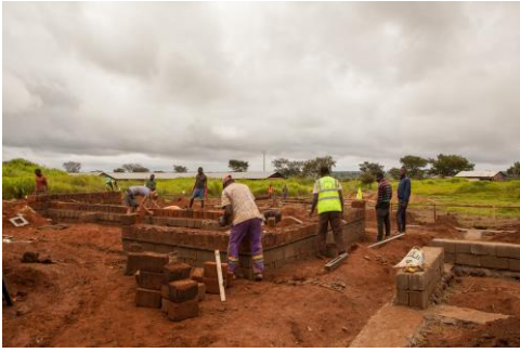
Baustelle des Gästehauses vom Krankenhaus in Ngaoubela, Kamerun © TUM DesignBuild
