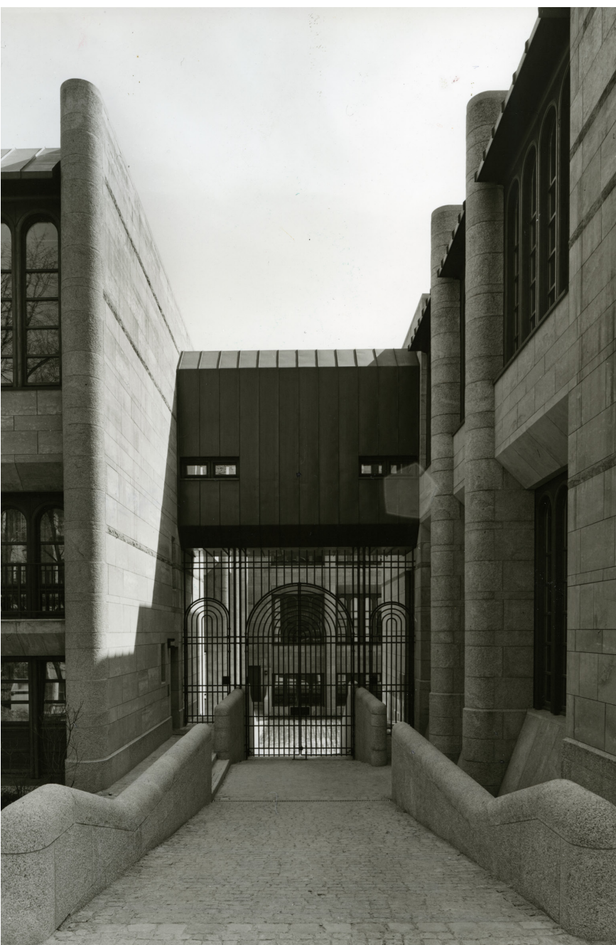
Abb8: Architekturmuseum der Technische Universität (1975-81): Neue Pinakothek - Außenansicht Zugang Innenhof.
