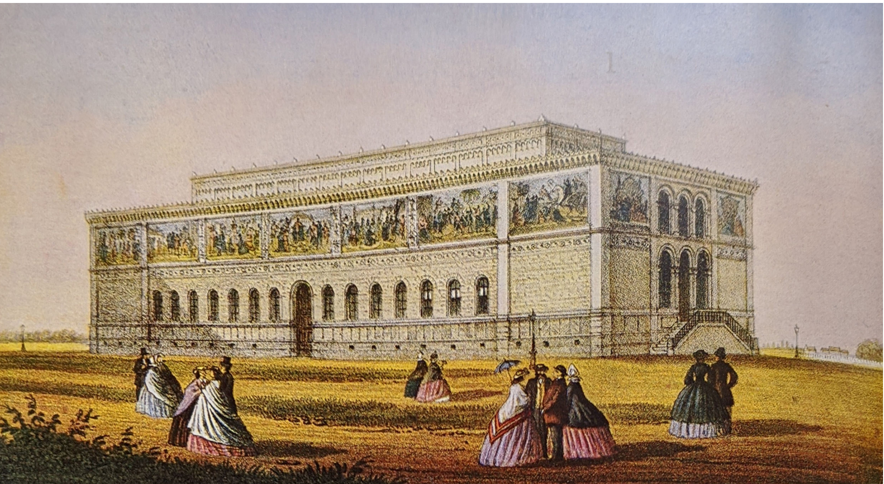
Abb4: Lenz, Christian (1989), S.6: Neue Pinakothek - Ursprünglicher Bau.
